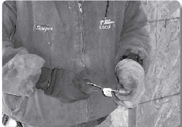
Problema: Cepillado manual de tubos de cobre
