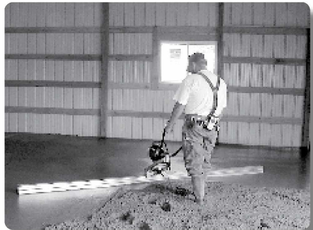
Solución: Uso de una niveladora motorizada
