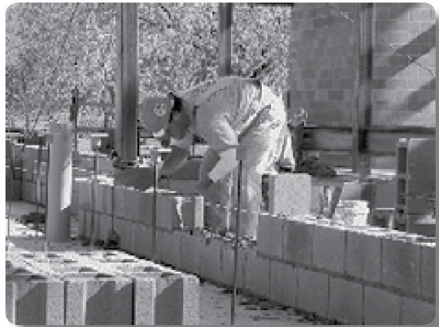
Problema: Instalación de bloques de concreto estándar
