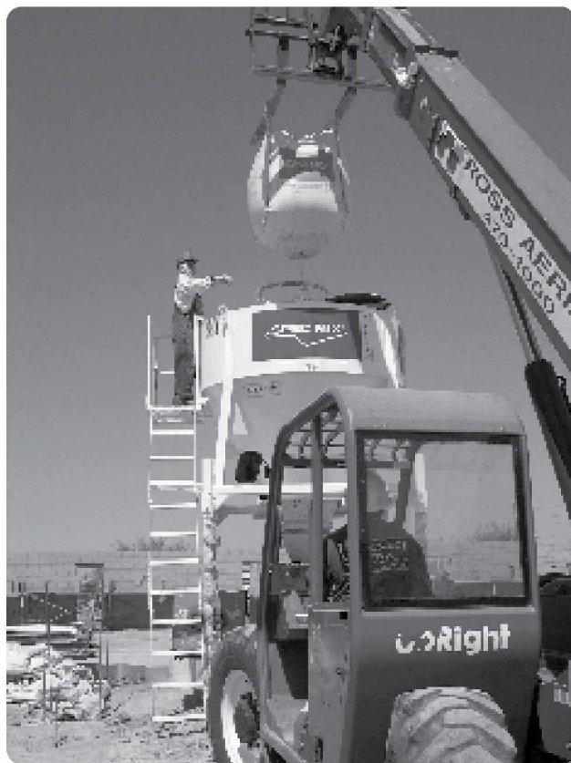
Solución: Carga de un sistema de silo
