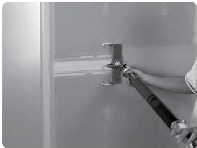
Solución: Sistema de acabado neumático
