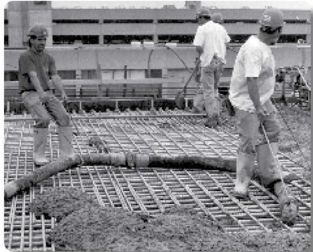
Solución: Halar la manguera con una base y gacho para deslizar
