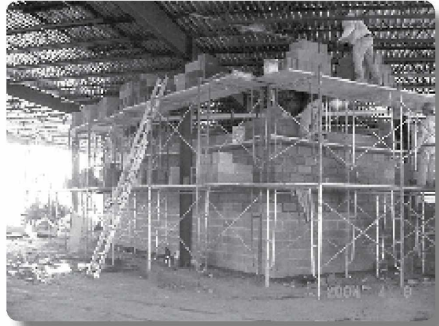
Problema: Andamio convencional sin estructura de protección
