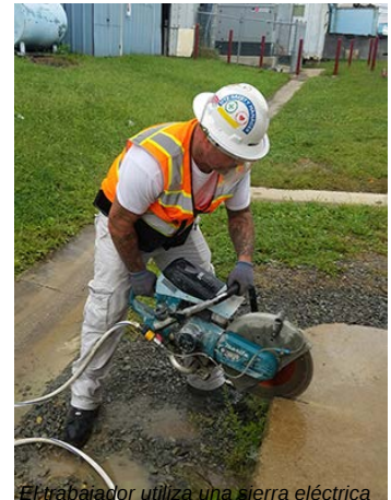
El trabajador utiliza una sierra eléctrica manual con sistema integrado de suministro de agua. (Crédito de la foto: OSHA)
