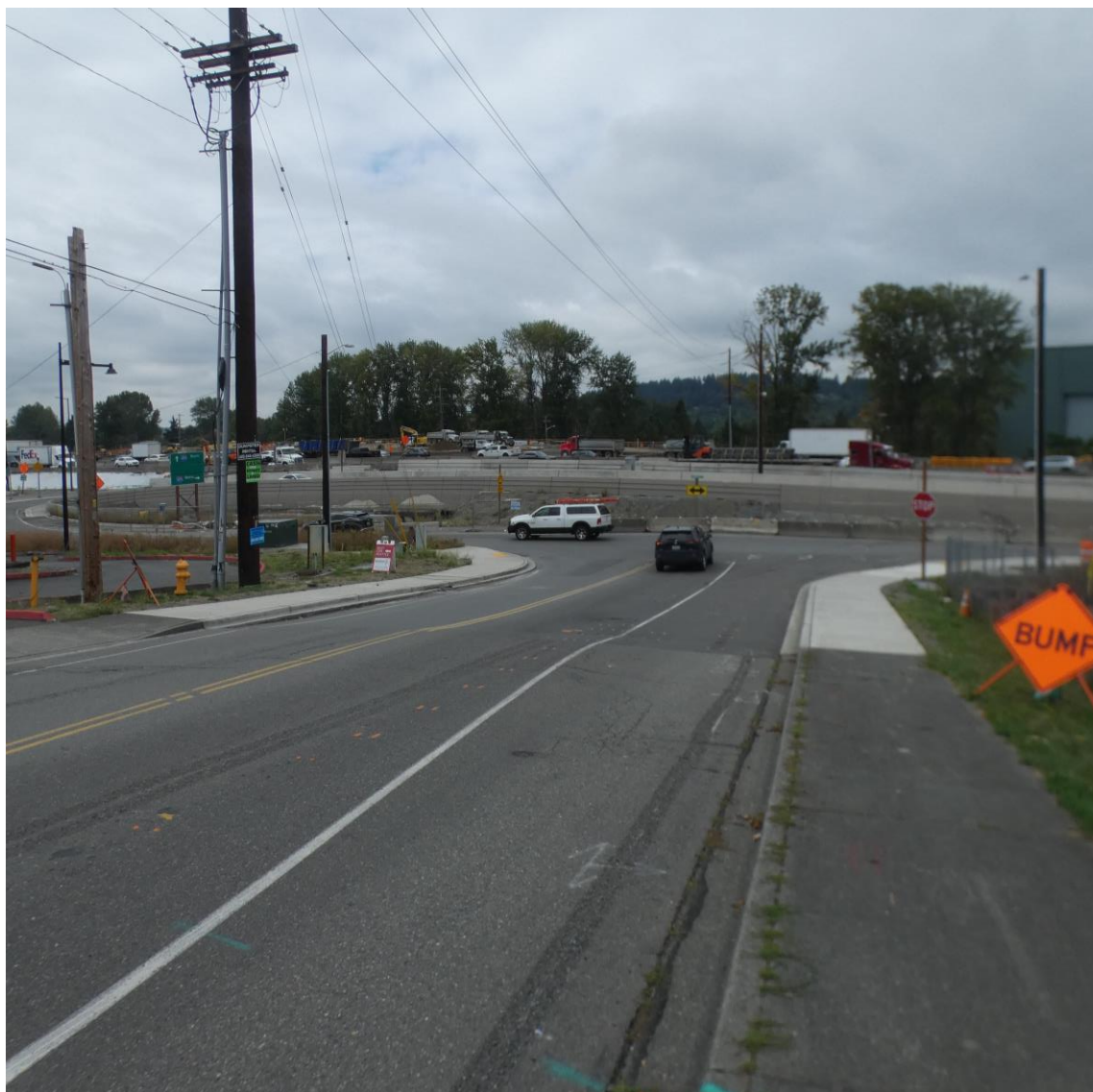
Imagen 2. Colina en la que fallaron los frenos, con una intersección en T en la parte inferior, donde chocó el camión.
