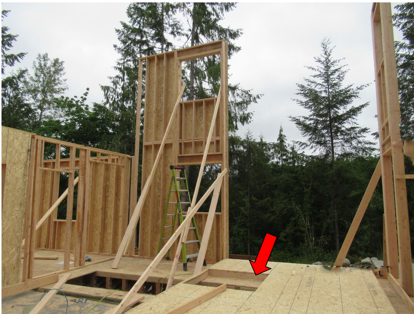
Imagen 5. Una flecha indica el sitio aproximado en el que el instalador de estructuras fue golpeado por la pared y cayó por la abertura.
