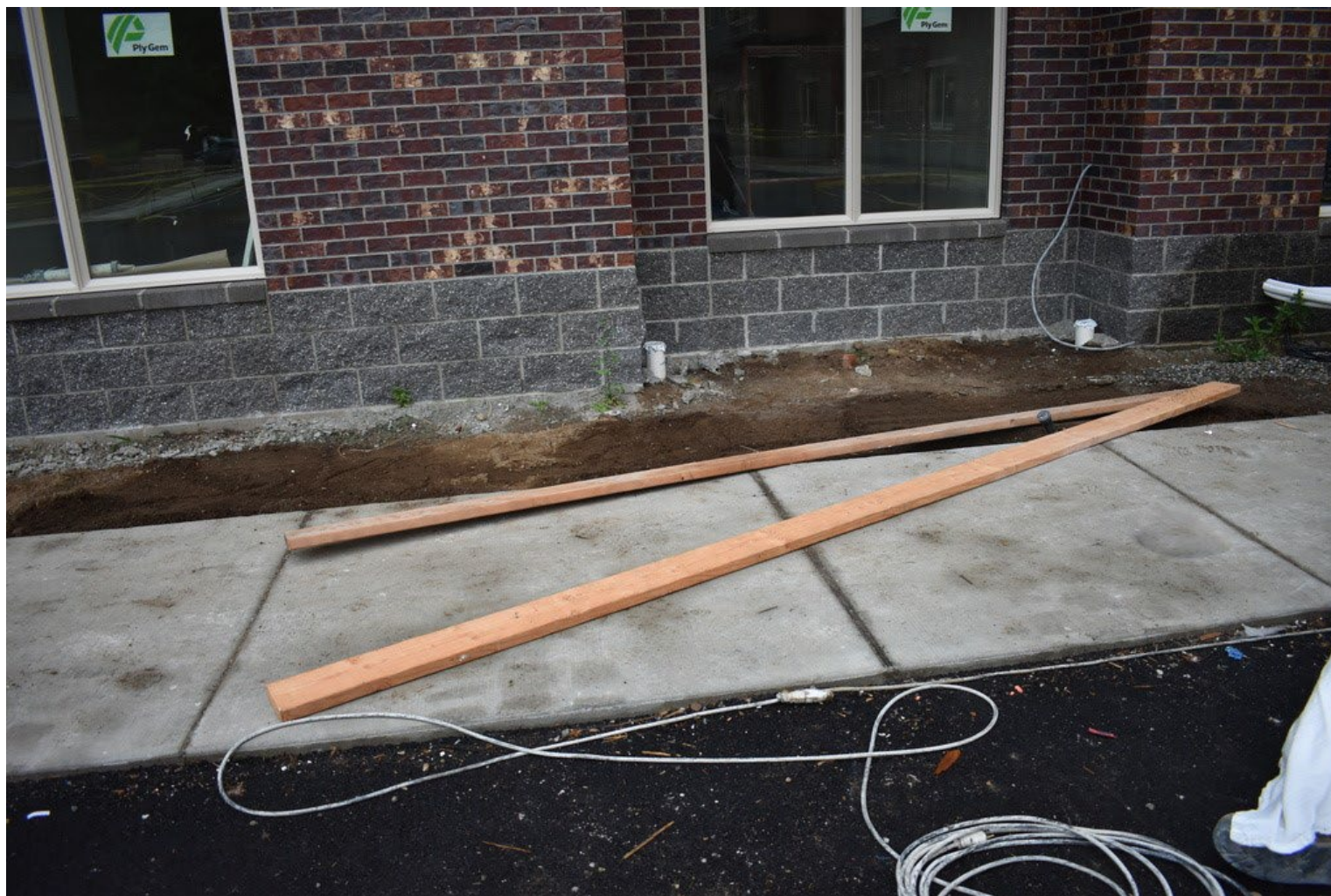
Imagen 6. Barandillas que se soltaron.
