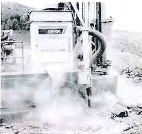
Figura 2: Atmósfera cargada de polvo típica creada por las operaciones de perforación de rocas.
