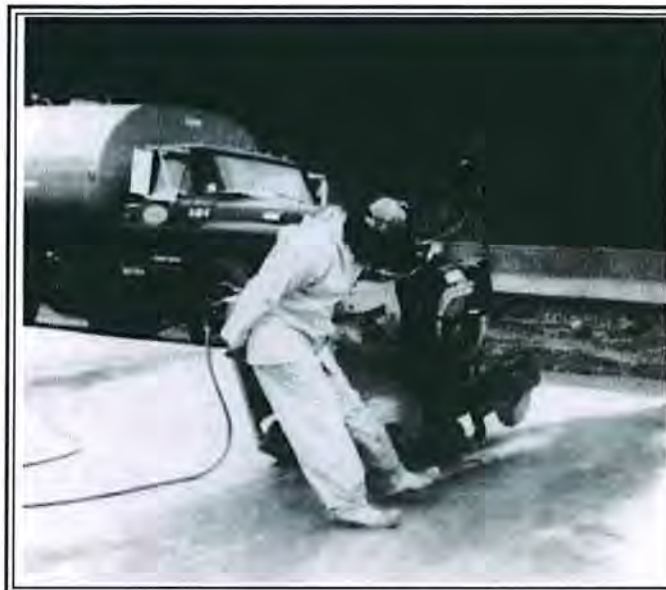
Figura 6. Aserrado de pavimento de hormigón que contenía sílice cristalino durante la construcción de una carretera
