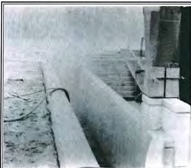
Figura 1. Limpieza con chorreadora de material abrasivo de hormigón que contenía sílice cristalino (la arena de sílice es el abrasivo).
