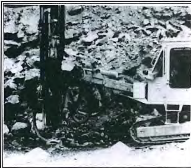
Figura 5. Perforación de roca que contenía sílice cristalino durante la construcción de una carretera.
