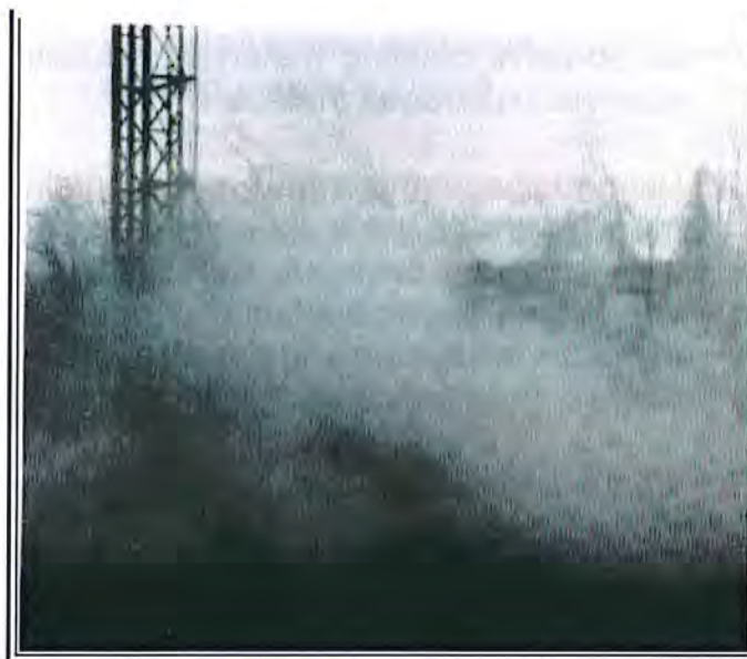
Figura 3. Perforación de roca que contenía sílice cristalino durante la preparación del lugar de edificación.
