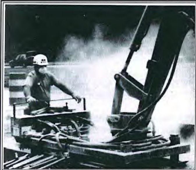
Figura 4. Perforación de pavimento de hormigón que contenía sílice cristalino durante la reparación de una carretera interestatal.
