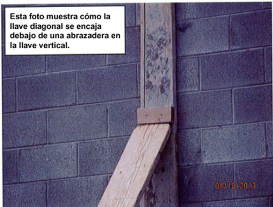
Fotografía 1. Listón superior del puntal del muro. (Fotografía cortesía de la TOSHA.)
