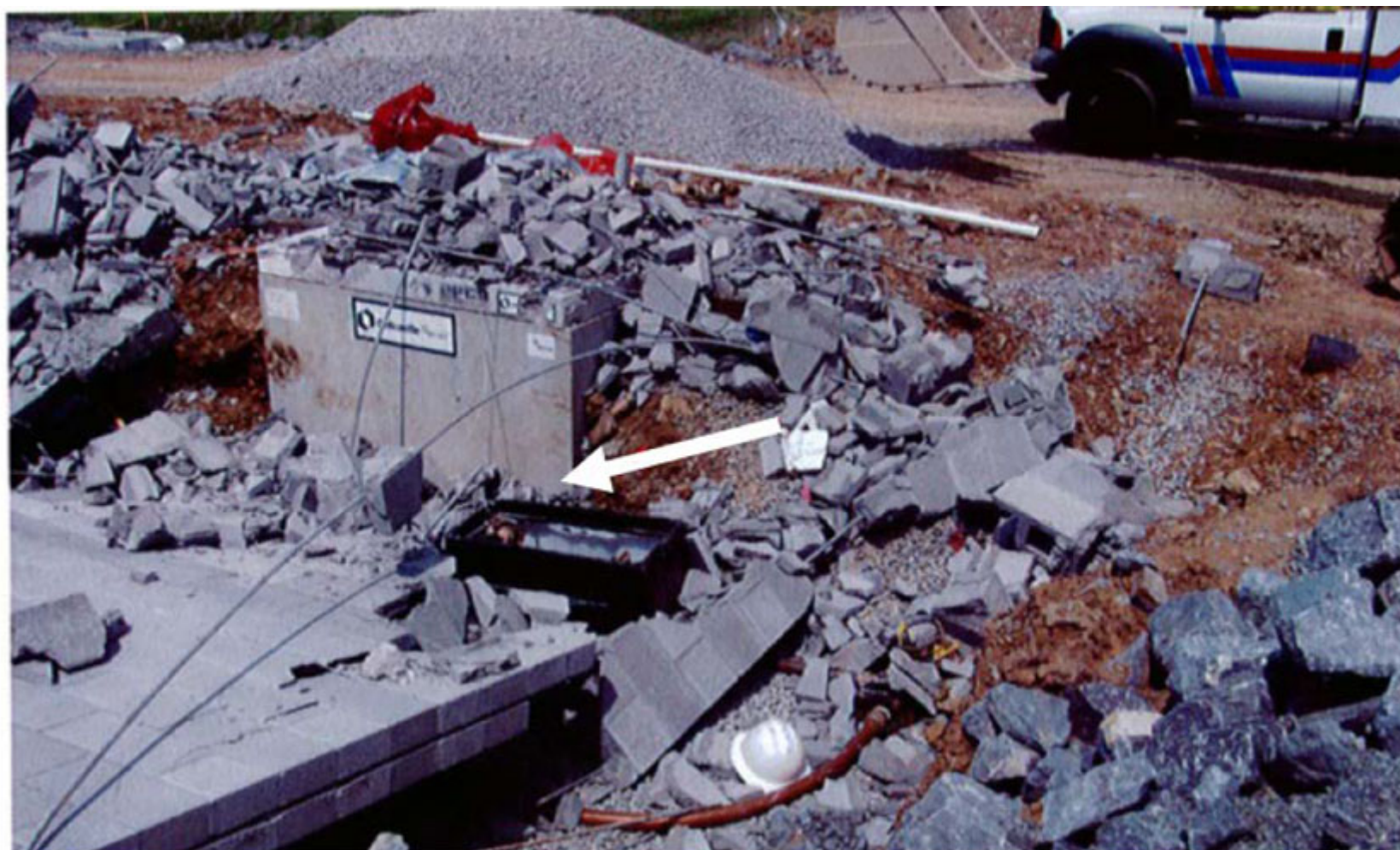
Fotografía 4. Caja de cemento del medidor La flecha indica dónde trabajaban tres empleados de excavación. (Fotografía cortesía de la TOSHA.)
