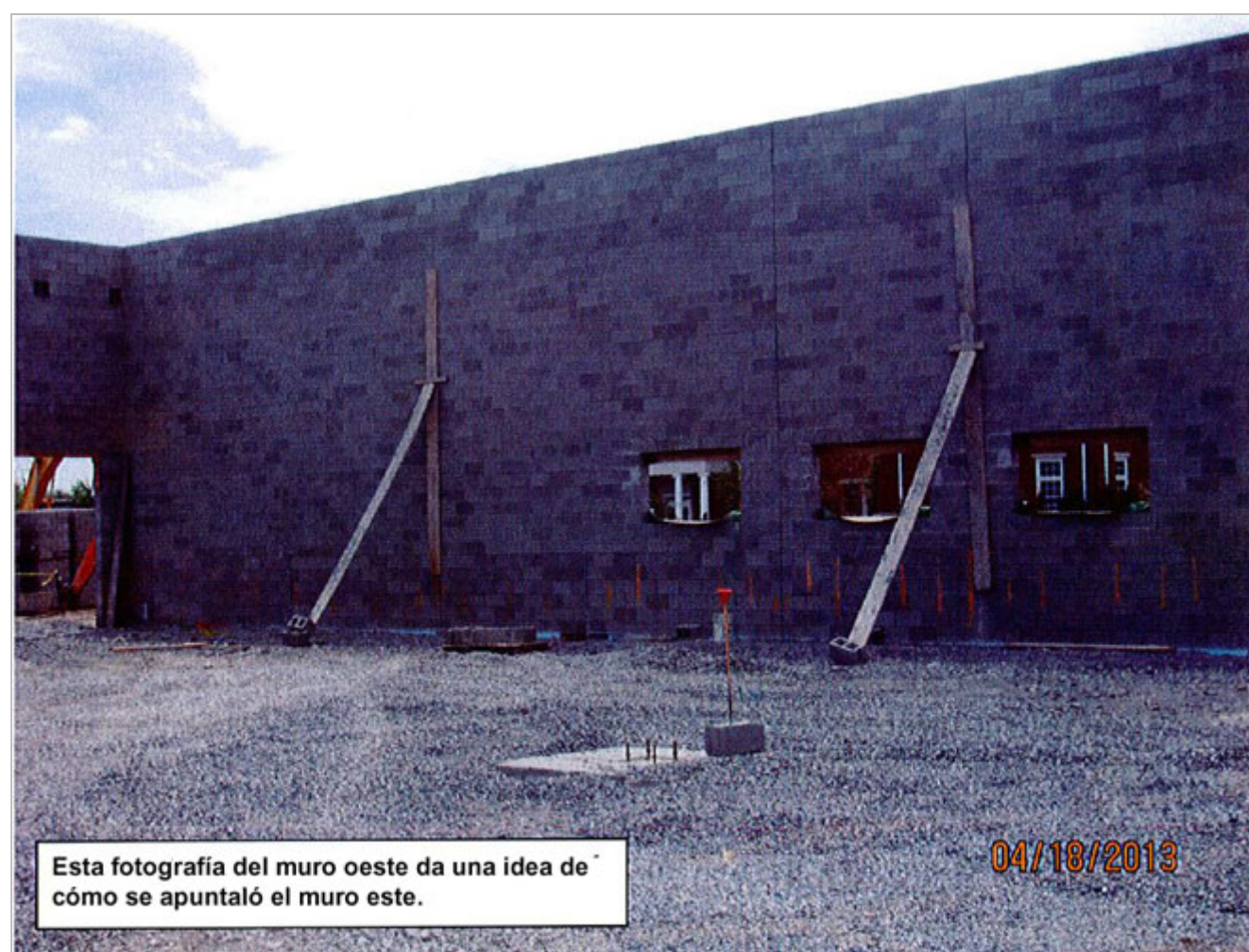
Fotografía 3. Apuntalamiento del muro interior. (Fotografía cortesía de la TOSHA.)
