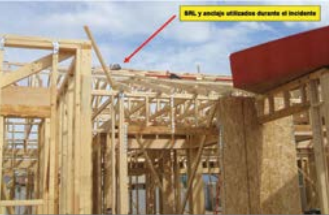
Fotografía 2: Anclaje y SRL del PFAS utilizado por el trabajador. Todos el equipo se dejó en el lugar para la fotografía.
