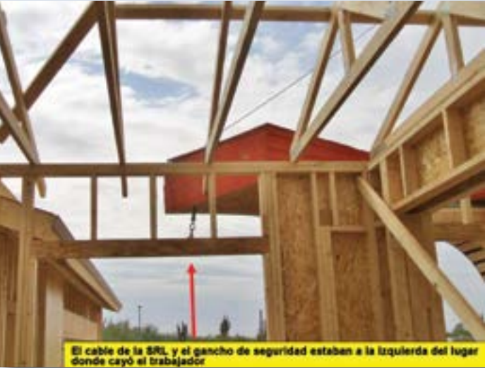
Fotografía 4: Cable de la SRL y gancho de seguridad donde se detuvo la caída. Observe la cercanía al cordón superior de la viga y la pared, y la ruta de la cuerda sobre la parte de atrás de la viga.
