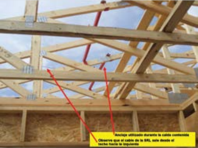
Fotografía 3: Parte inferior del sistema de vigas y anclaje utilizado en la caída contenida.
