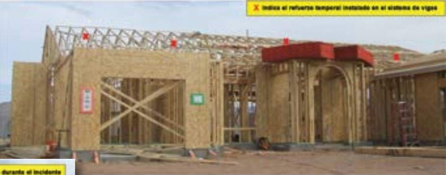
Fotografía 1: Construcción de la estructura de madera de la casa después de que se instalaron y fijaron las vigas. Se apilaron unos OSB sobre la entrada a la derecha cuando el trabajador se cayó.
