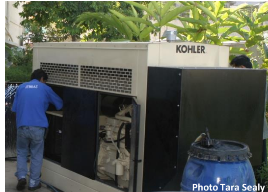
Diesel generator (100 kVA)
