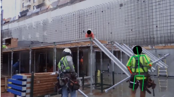
k. Carry a shoring post
