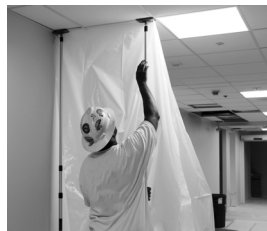
Trabajador que establece un área de contención durante una clase de entrenamiento de ICRA.
