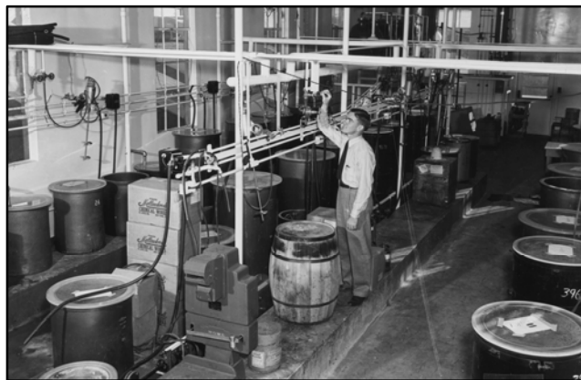
En este cuarto para la preparación de las soluciones del Sitio DP del Oeste, los productos químicos eran mezclados en tinajas o tinas grandes y alimentaban por medio de la gravedad a las operaciones que se realizaban por debajo de ellas.
